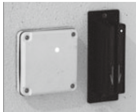
カードリーダ(5号館・2号館)
